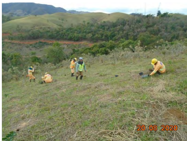
Foto 9 – Equipe de campo desenvolvendo a atividade de replantio no sublote 8.11-A.
